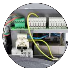
PROGRAMMATORE ELETTRONICO CON MORSETTI ESTRAIBILI
